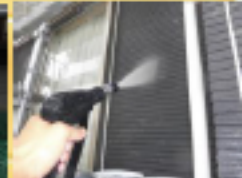
高圧洗浄(外壁)
