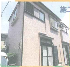
壁の色はアステック 8088モカです
