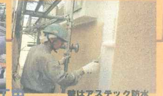
壁はアステック防水 塗料でヒビ対策
