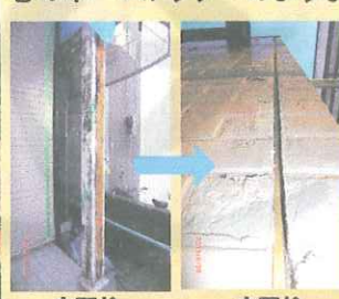
玄関柱 (解体状況)
