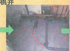
洗面室の新規配管
