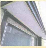
軒下はケイカル板を張りました
