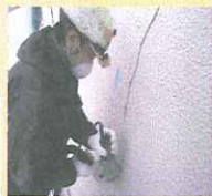
モルタルのヒビはV溝を掘り、シーリング・カチオンセメントで埋めました
