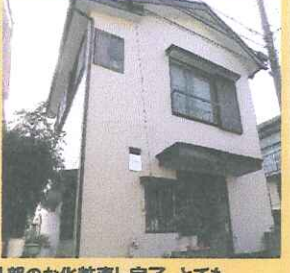
外部のお化粧直し完了。とても綺麗に仕上がりました♪
