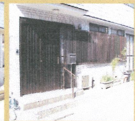
新玄関(施工後)
