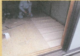
内部床工事の際も、 断熱材を敷きつけて あります。
