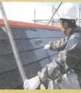
施工後 ピンク色から一変!グレー系でまとめました!屋根も壁も遮熱塗料なので、今年の夏は室温の低下を感じて頂けそうです♪
