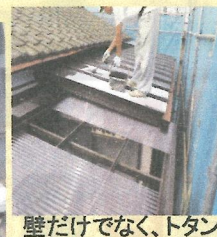
壁だけでなく、トタン屋根も塗装しました。サビ止め塗布後の仕上げ塗りです。
