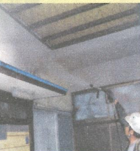
塗装の前は必ず高圧水で洗浄します！
