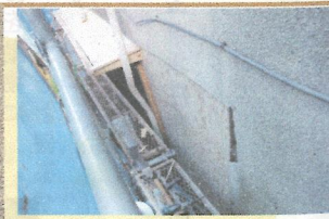
戸袋を撤去して壁に。庇は作り直しました。
