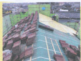
瓦の下地ベニヤ上貼りし、防水シートも新しく敷きます。
