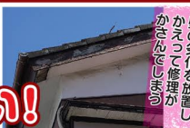
少しの痩せや剥がれでも水が浸入し、内部が腐食します。
